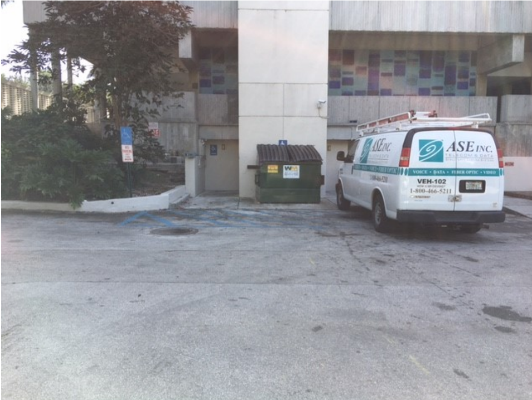
ADA Access Area
